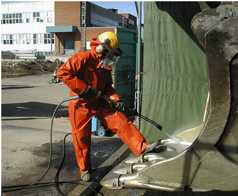
Bild 4. Rengöring av grävsropa efter kontakt med kraftigt förorenad jord (Foto: Helena Fürst).
