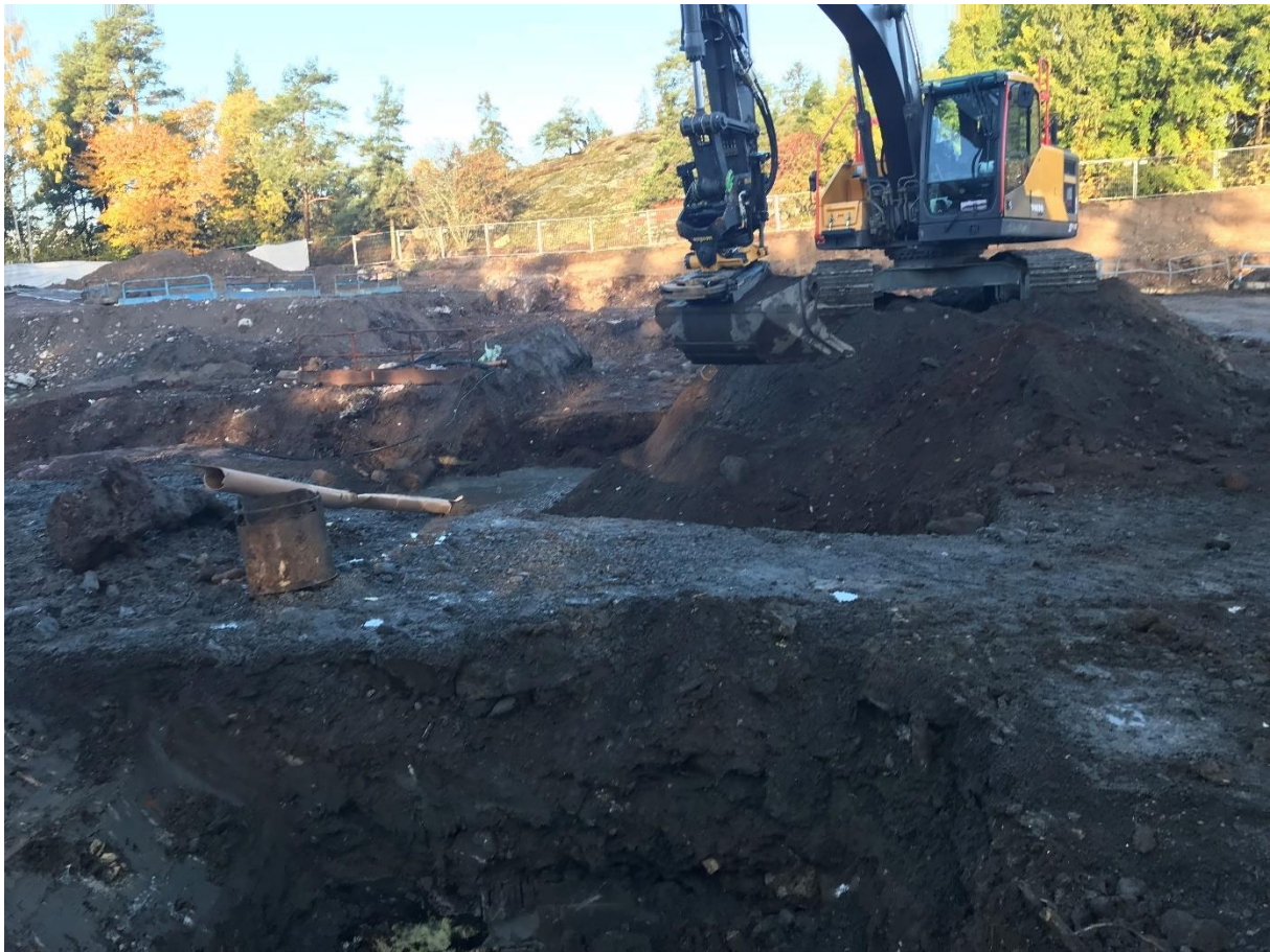
Bild 17. Entreprenadarbete i förorenad jord (Foto: Erik Magnusson).
