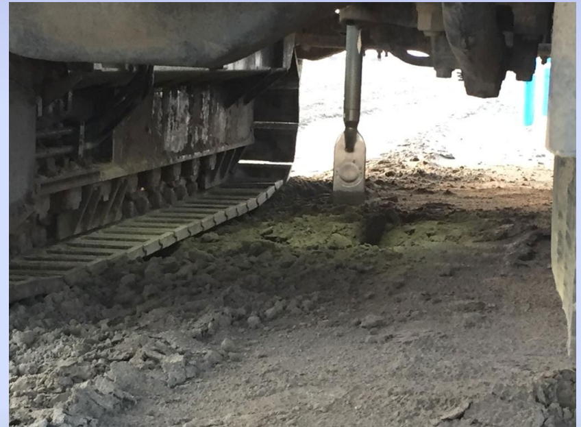
Blade penetration (~ 25 ton)
