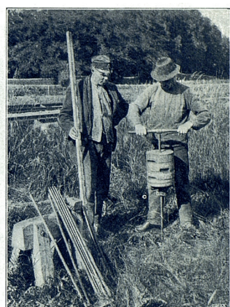
Fig. 12. Sondborren nedborras genom vridning. (Klämman är av annan typ än den här föreskrivna).
