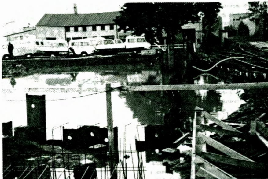
Fig 3. Schakt i lera som vattenfylld på grund av mycket bristfällig uppstapad spont. Ett skred in i schaktgropen har orsakat brott på vattenledning utanför sponten
