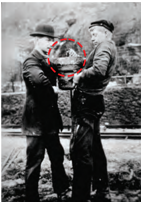
Figur 1. Manuell viktsondering där förmanen (t.v.) håller i stångtoppen för att notera vibrationer vid penetration genom friktionsjord.
