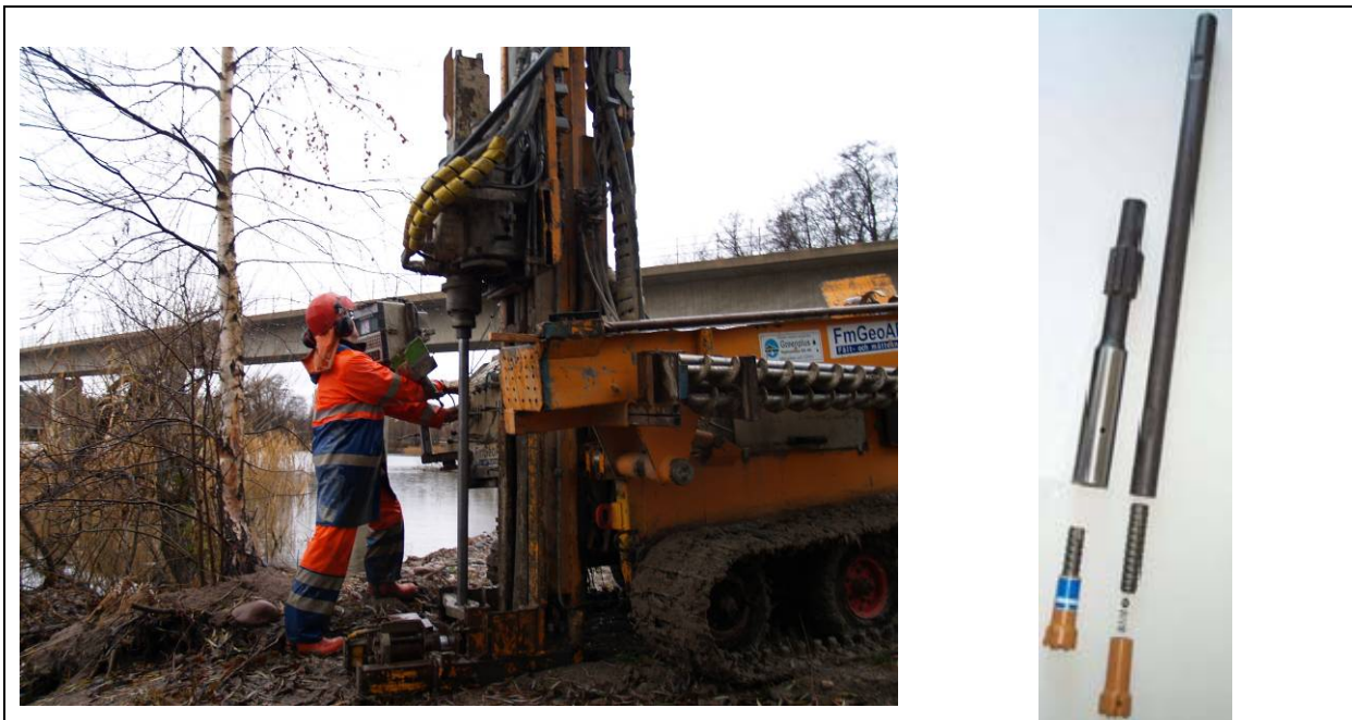
Figur 2: Geostång \varnothing 44 med 57 mm stiftborrkrona och backventil
