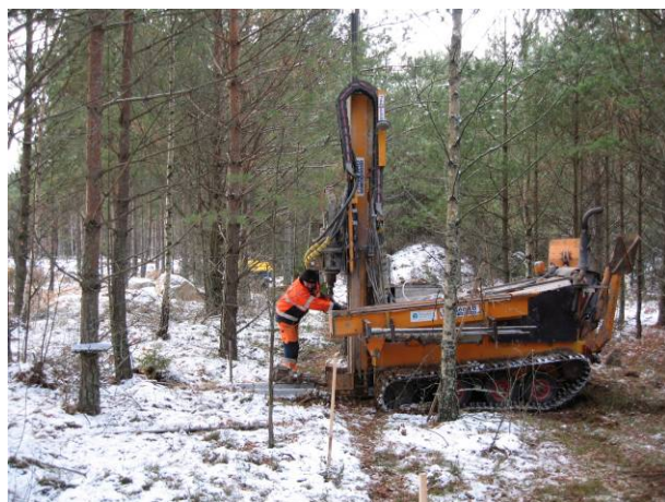
Figur 10: Sondering vid Kolbytteomon med Geotech 705DD
