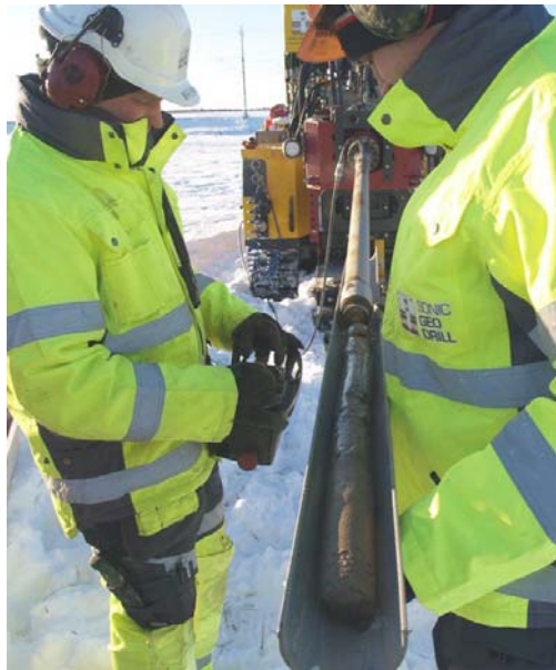
Figur 8.18 Uttryckning av prov vid sonicborring.
