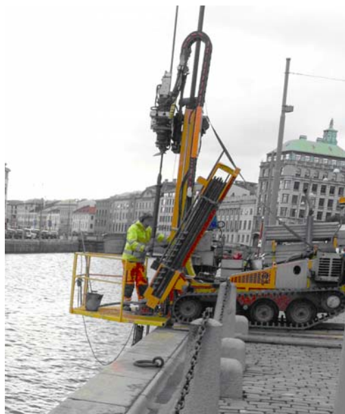
Figur 11.5 Bandvagn med plattform som arbetsyta.
