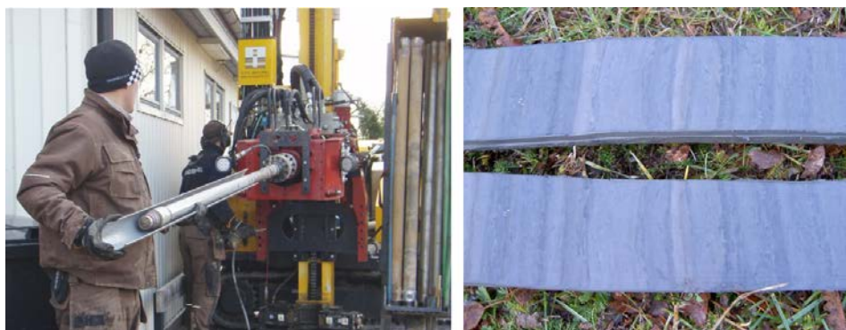
Figur 10 Sonicborrning och borrkärna (Geosigma)
