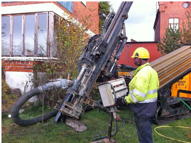
Figur 9 Foderrörsborrning (Geosigma)
