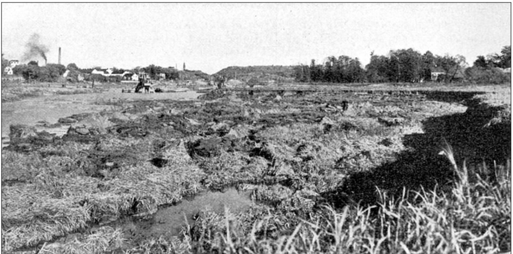
Det bakåtgripande skredet vid Hammarbyledens muddring 1920.
