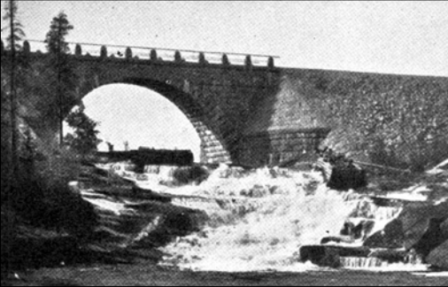
Naturstensbro vid Pakkoselet på Inlandsbanan.
