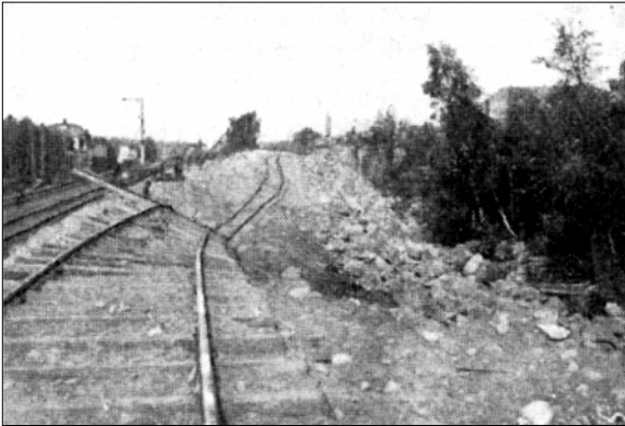
Järnvägsbanken vid Djurgården, Finland 1923.
