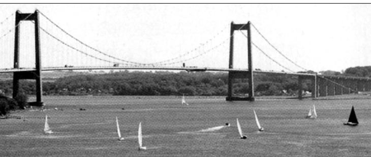
Lilla Bältsbron I, fackverksbro, grundlagd 1936 efter E L Mertz undersökningar. Lerdjup ca 100 m, skjuvhållfasthet ca 100 kPa, sättningar intill år 2000 ca 0,6 m. Lilla Bältsbron II (bilden), hängbro, grundlagd på 1960-talet med kohesionspälår.
