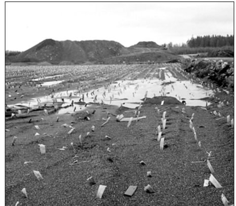
Luftfartsverkets vertikaldränar vid Arlanda 1999 (60 år efter patentet).
