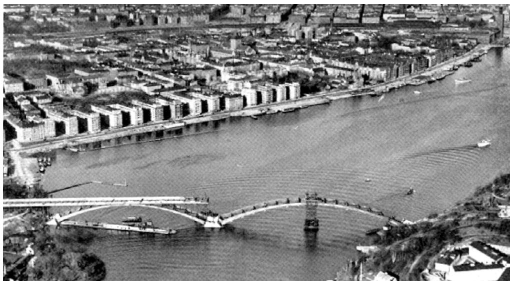
Västerbron, Stockholm under byggnad 1932–1935.
