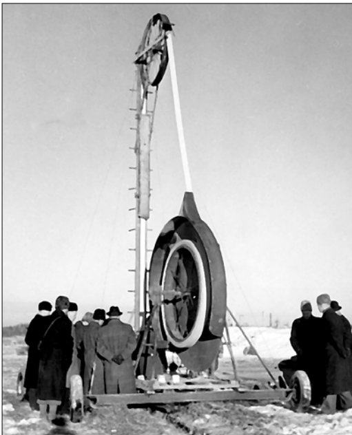
Kjellmans vertikaldränering provas vid St Mellösa, Upplands Väsby, 1945 (flygplatsalternativ).
