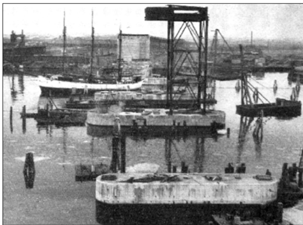
Färdiga grundlagda brofundament, Götaälvbron 1939.
