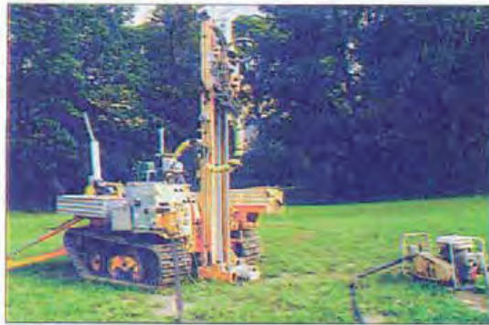
Fig 7:19 Hydraulisk Jb-maskin (Geotech 604) med vattenpump för spolning.
