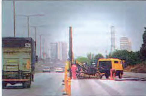
Fig 7:20 Tryckluftdriven bormaskin (Roc 601) med 20m 3 kompressor för drivning och spolning.
