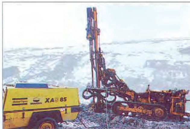
Fig 7:21 Hydraulisk bormaskin (Klenm 806) med kompressor för luftspolning. Används för borring till stora djup och drivning av grova foderrör.
