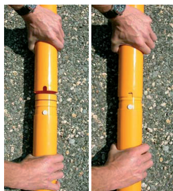
Foto 1 Skarvning med snäppkoppling.
