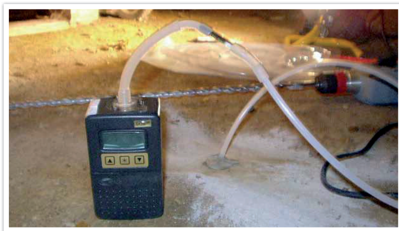
Figur 6 Pumpad indirekt provtagning av porgas på adsorbenttrör, från mark under en byggnads grundläggning (Foto: Golder Associates). Notera tätningen vid slanggenomdragning.
