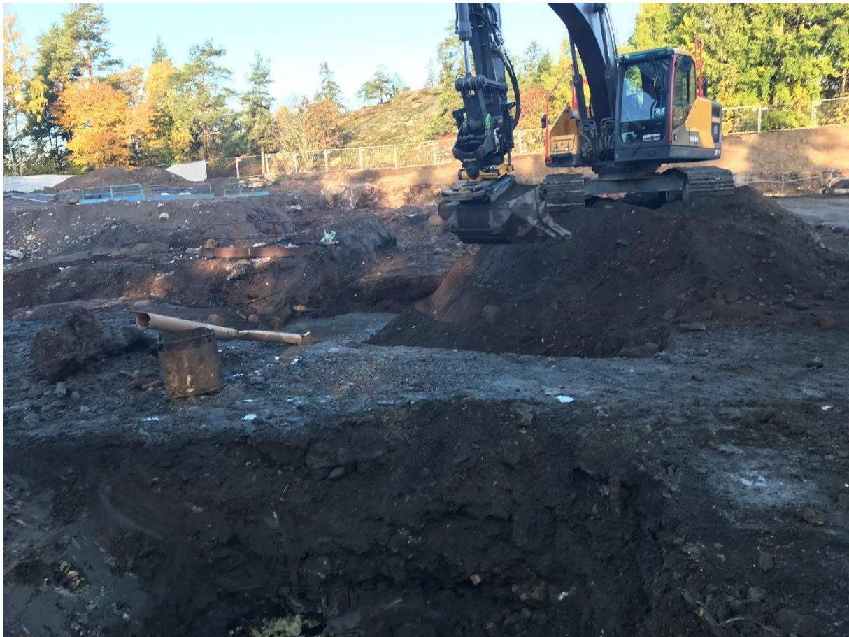
Bild 17. Entreprenadarbete i förorenad jord (Foto: Erik Magnusson).
