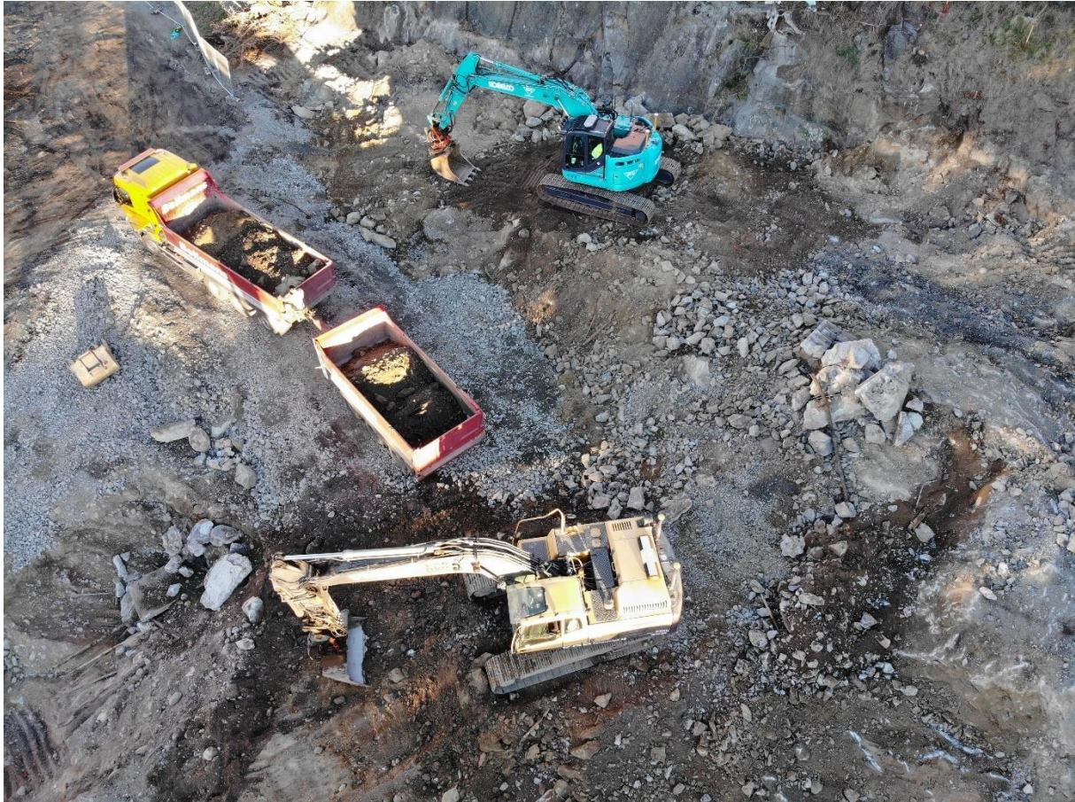
Bild 8. Anläggning av rena körvägar inom en schaktsanering (Foto: Johannes Hedtjärn).
