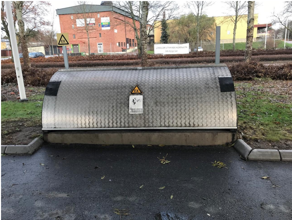
Bild 10. Bensinstationer är miljöer där explosionsrisk förekommer och det är viktigt att använda EX-klassad utrustning inom skydds zoner (Foto: Erik Magnusson).
