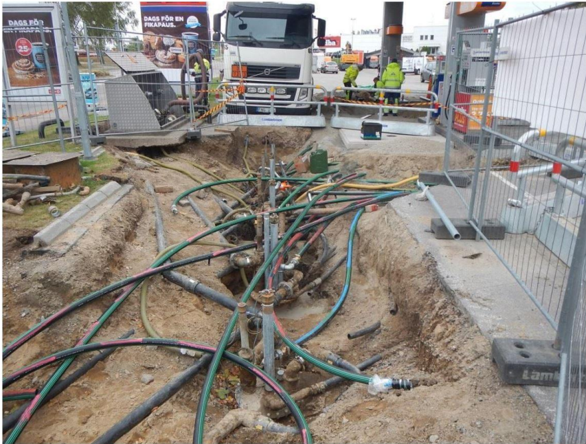
Bild 14. Exempel på avspärning vid annan pågående verksamhet (Foto: Mårten Osanius).
