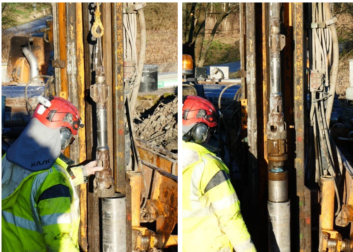
Figur 19 Kärnhämtare med vajer spel (Foto: B Dehlbom, SGI).
