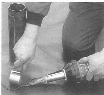
Figur 5:5. Handfön. Handhållen utrustning med ett munstycke som blåser varmluft. Varmluften smälter geomembranet mellan skikten som sedan pressas samman för hand med en tryckrulle.
