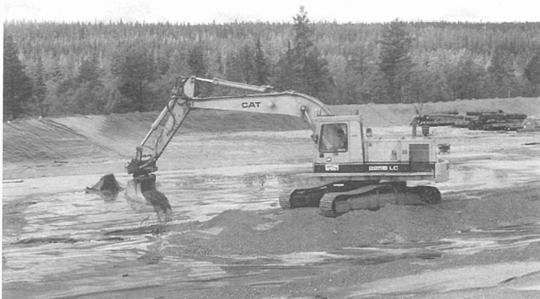
Figur 8:1. Utläggning av skyddsskikt och skyddstäckning.
