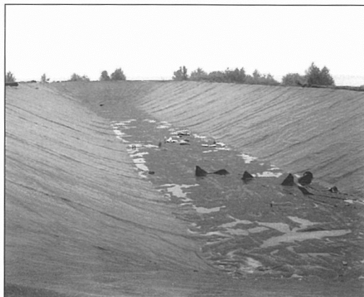
Figur 2:7. Exempel på tätskikt i damm.
