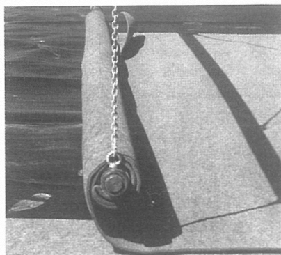
Figur 6:1. Utläggning av skyddsgeotextil.
