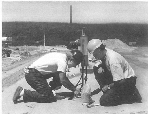
Figur 5:12. Kalibrering av nukleär densitetsmätare genom densitetsmätning med vattenvolymeter (mätning på bentonitblandad sand, nukleär-mätaren i bakgrunden).
