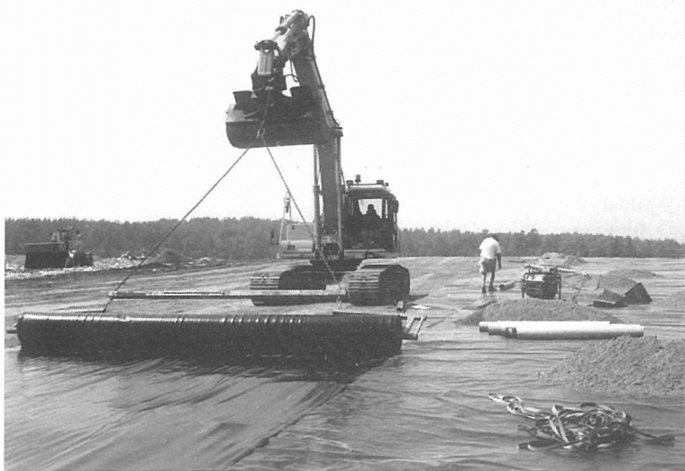
Figur 8:2. Utläggning av geomembran.
