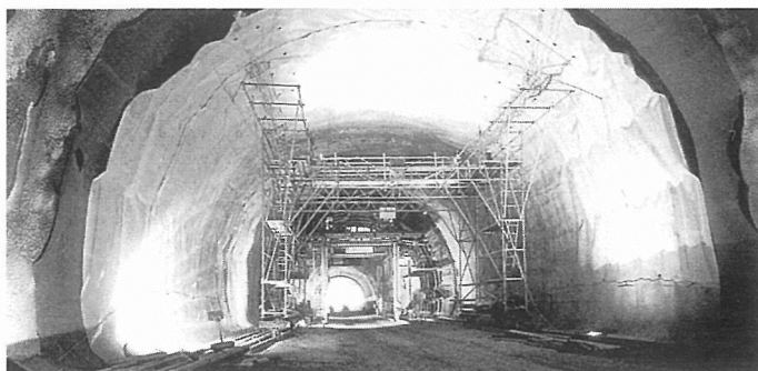
Figur 2:8. Tunneltätning under montering.
