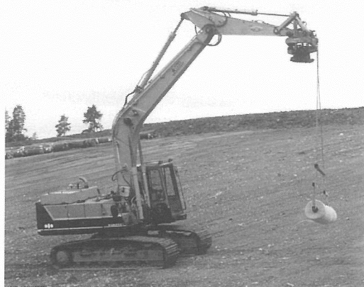
Figur 5:1. Exempel på lyftok hängande i grävmaskinsarm.
