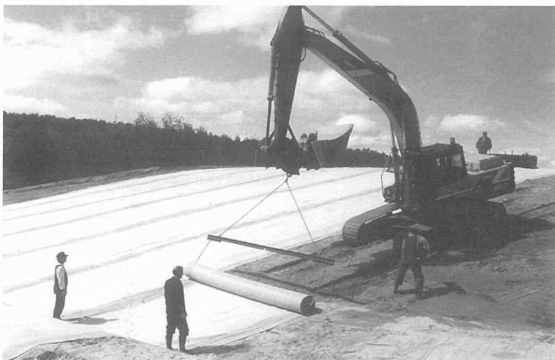
Figur 5:10. Utrullning av lergeomembran med grävmaskin och lyftok.
