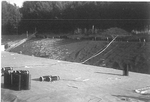
Figur 6:3. Armerad slänt med geonät.
