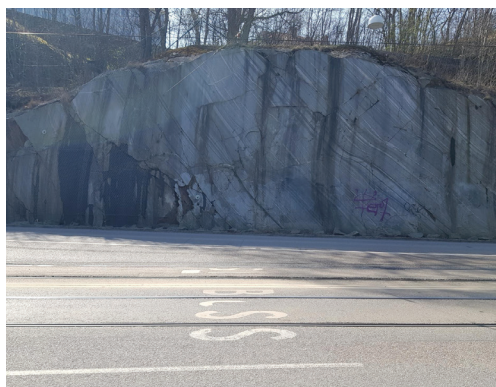
Fig 1.7 Sågad bergsskärning i gnejs. Foto: U Lindblom
